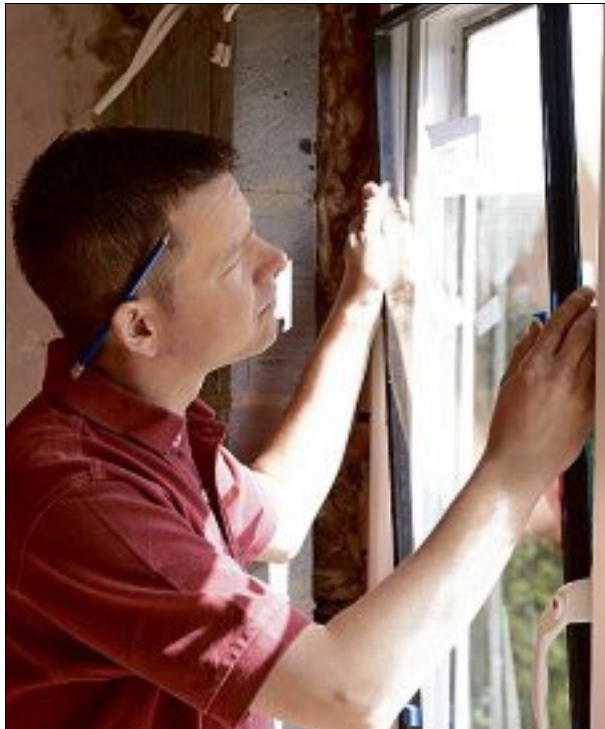
DÉCIDER. Outre le type de travaux à effectuer, encore faut-il savoir comment financer un tel chantier. PHOTO THINKSTOCK
